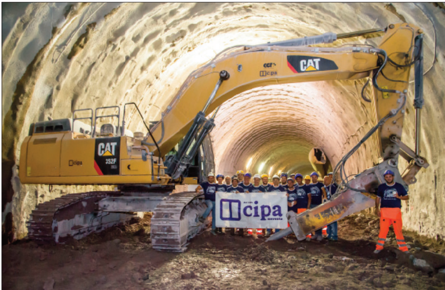
ISRAELE CIPA Costruzione galleria
