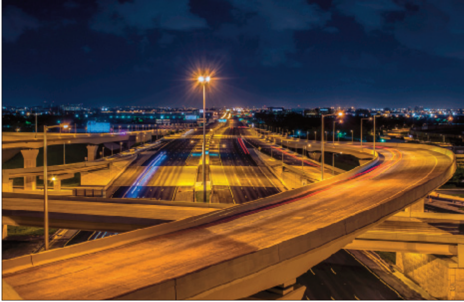
USA CONDOTTE Svincolo autostradale
