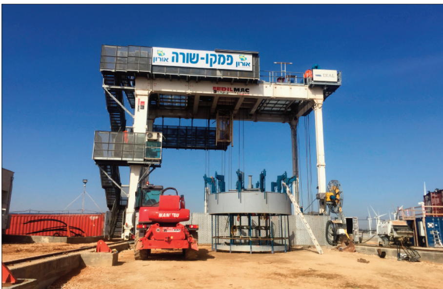
ISRAELE EDILMAC Pozzo per Centrale Idroelettrica
