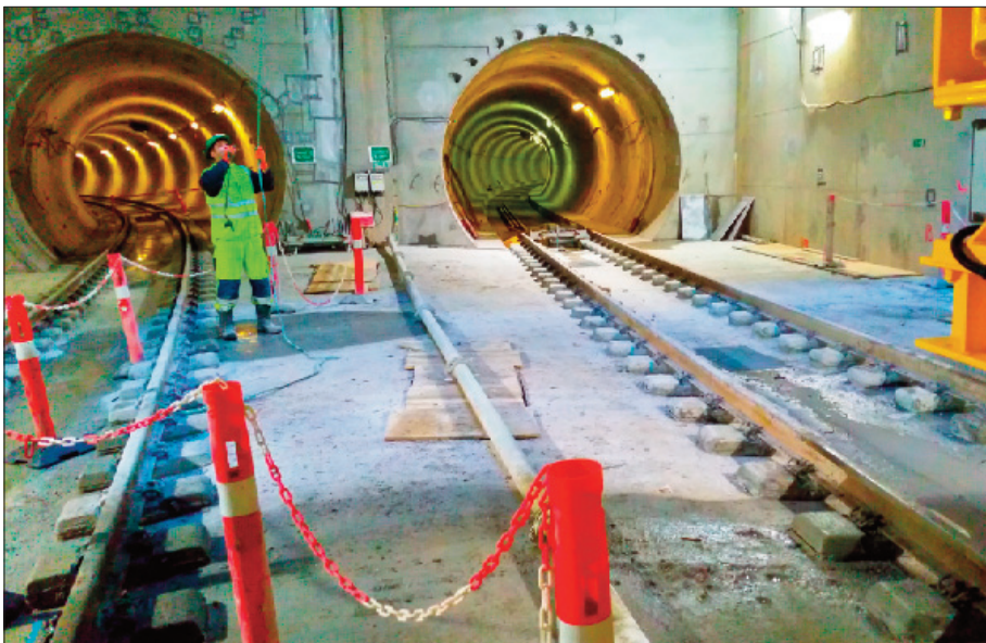
DANIMARCA GCF Metro Copenaghen
