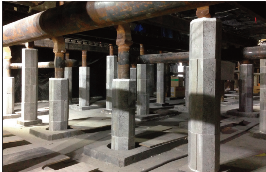
MESSICO FERRETTI INDUSTRIAL SERVICES Rivestimento refrattario - forno acciaieria
