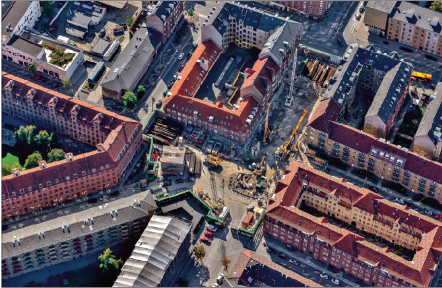
DANIMARCA I.CO.P Opere Fondazionali per Metropolitana di Copenaghen
