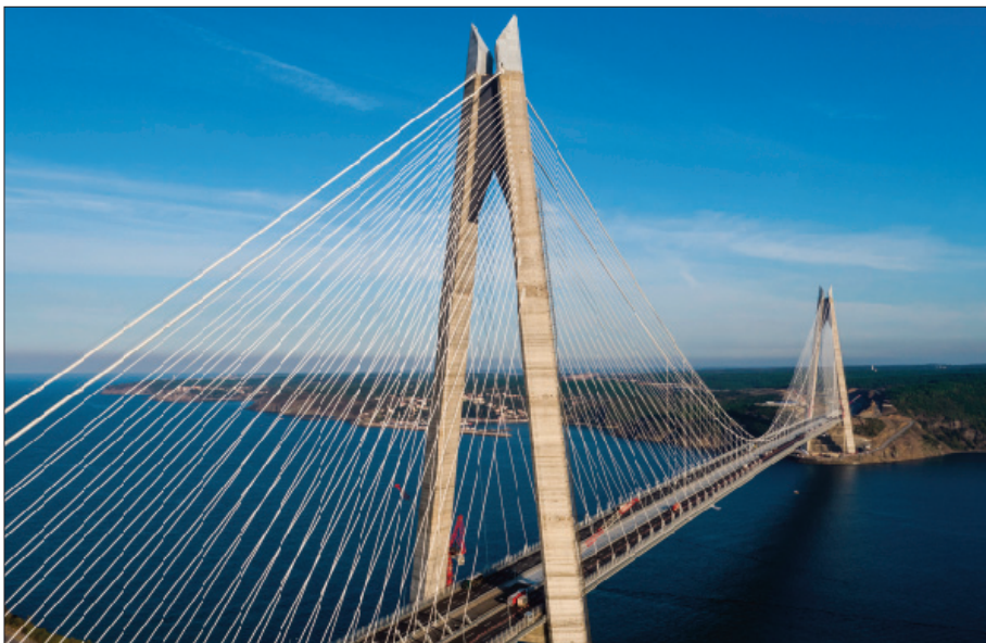
TURCHIA ASTALDI Terzo Ponte sul Bosforo
